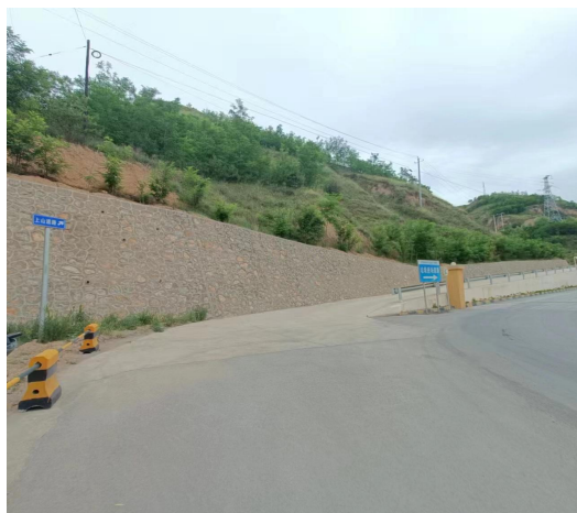
进场道路与上山道路连接处（护坡）
