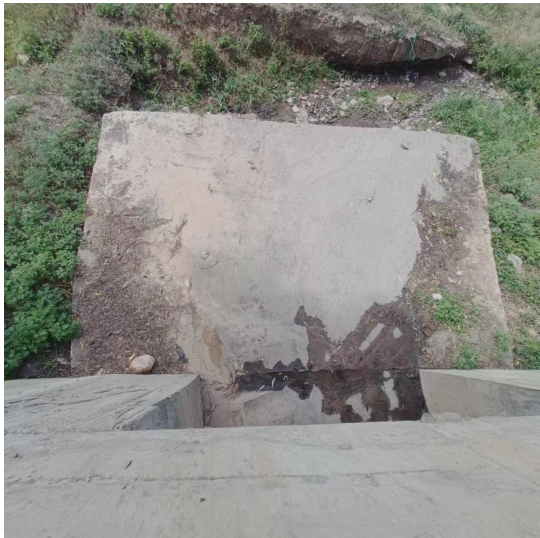
排水渠通向大岔河口
