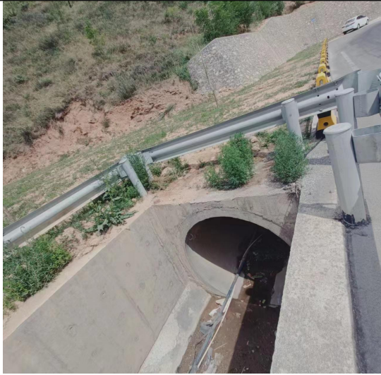
涵管与排水渠连接处
