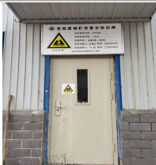
皇甫谧危废暂存间
