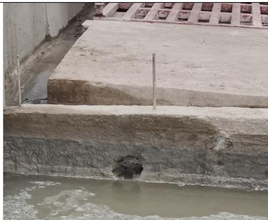
一级沉淀池进水口
