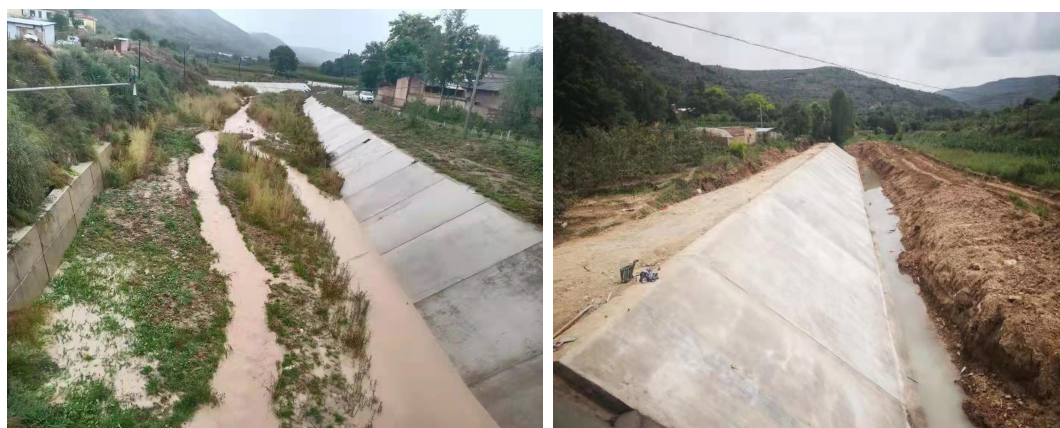
治理后河道现状
