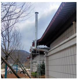
图 7 污水站 15m 高排气筒
