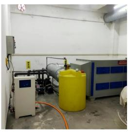
图 8 污水站加药装置
